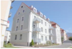
Sanierung eines 8-Familienhauses aus dem 19. Jahrhundert 3 Vollgeschoße mit Dachgeschoß, voll unterkellert Tiefgarage seitlich angebaut Sanierung mit Passivhauskomponenten Holzfenster mit Dreifachglas Komfortlüftung mit 80% Wärmerückgewinnung je Wohneinheit Innendämmungen mit mineralischen Baustoffen Kellerdecke und Dach  $U \leq 0,20 \text{ W/m}^2 \cdot \text{K}$
