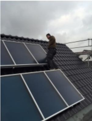
Installation einer grossen Solarthermieanlage zur solaren Warmwasserbereitung und Heizungsunterstützung in einem Mehrfamilienhaus mit Solvis MAX Gasbrennwertkessel mit 30 KW Leistung und Pufferspeicher 950 Liter
