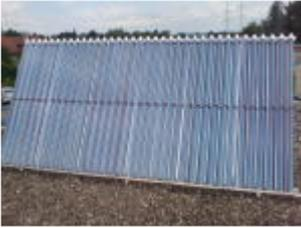
Installation einer Heizungsunterstützenden Solaranlage mit 7,2m<sup>2</sup> Vakkumröhrenkollektoren Fabr.CONSOLAR auf einem Flachdach in Kombination mit einer neuen Gasbrennwerttherme von WOLF
