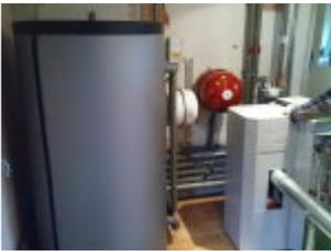
Installation einer ÖKOFEN Pelletheizung 8 KW mit hygenischer Trinkwasserbereitung und Solarvorbereitung
