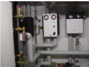
Einbau einer Ölbrennwertheizung mit Solaren Heizungsunterstützung 660 Liter Kombispeicher 4 St. Hochleistungskollektoren Anlage hydraulisch abgeglichen
