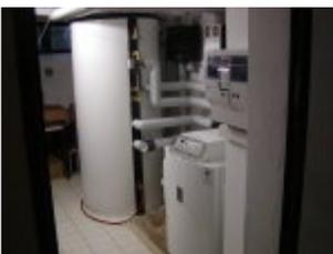
Einbau einer Ölbrennwert Anlage mit Solarer Heizungsunterstützung 4 St. Hochleistungskollektoren 660 Liter Kombispeicher
