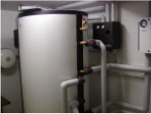
Einbau einer neuen Gas Brennwertanlage mit Solarer Heizungsunterstützung. Kombispeicher 660 Liter der Fa. Weishaupt 4 St. Hochleistungskollektoren Fa. Buderus Heizungssystem hydraulisch abgeglichen.
